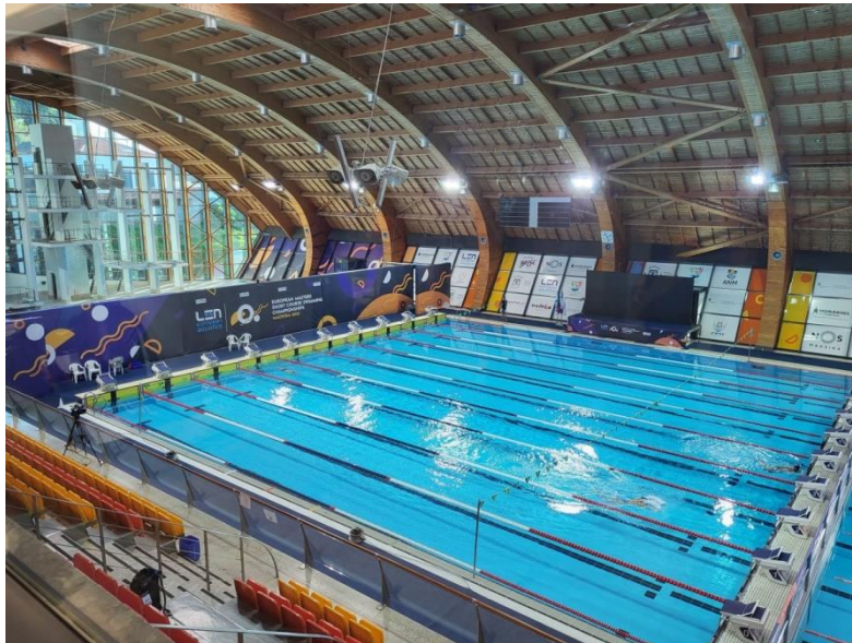
Halbiertes 50m Becken im Penteadá Olympic Pools Complex
